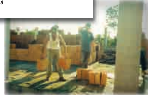
Construção em Paranaguá
