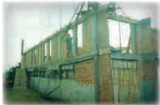
Construção em Paranaguá
