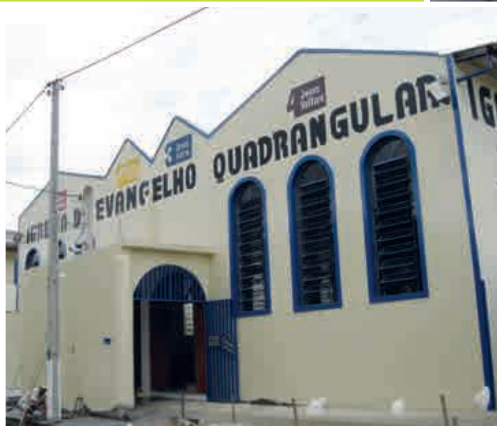
Fachada da igreja após a ampliação de 2005
