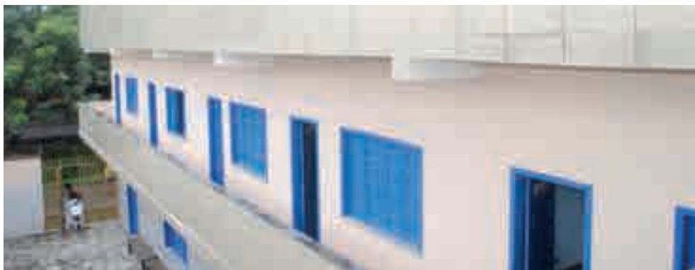
Prédio da EBQ, cantina, salão de eventos, banheiros e terraço (2012)
