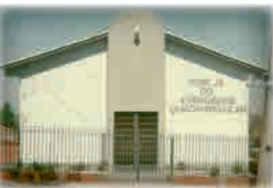
Construção em Paranaguá
