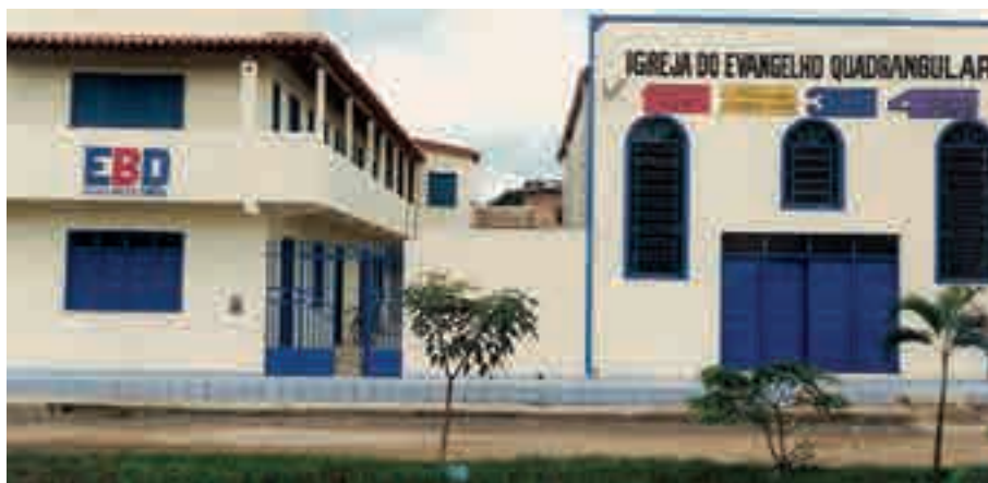
Primeira etapa do prédio da EBQ (2001)
